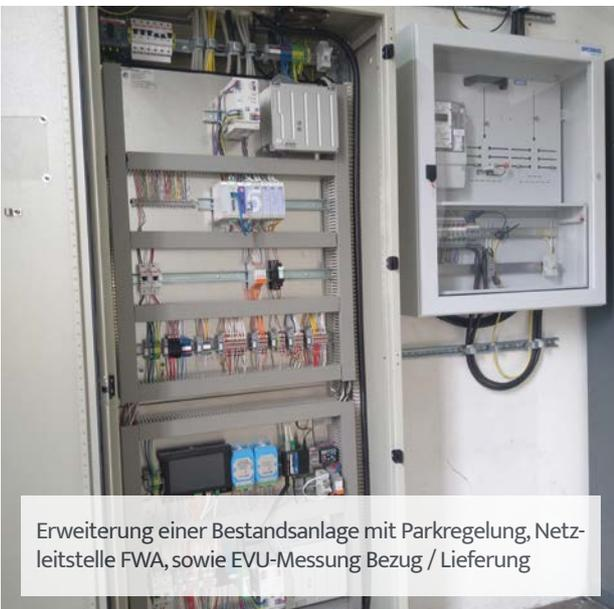
Erweiterung einer Bestandsanlage mit Parkregelung, Netzleitstelle FWA, sowie EVU-Messung Bezug / Lieferung
