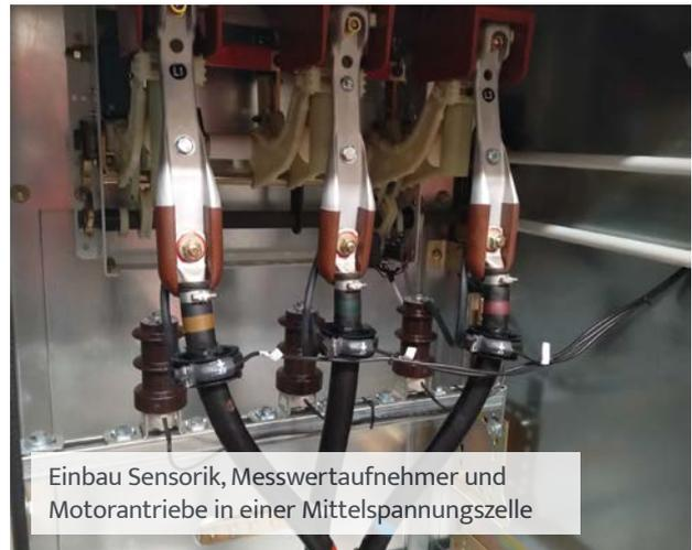
Einbau Sensorik, Messwertaufnehmer und Motorantriebe in einer Mittelspannungszelle
