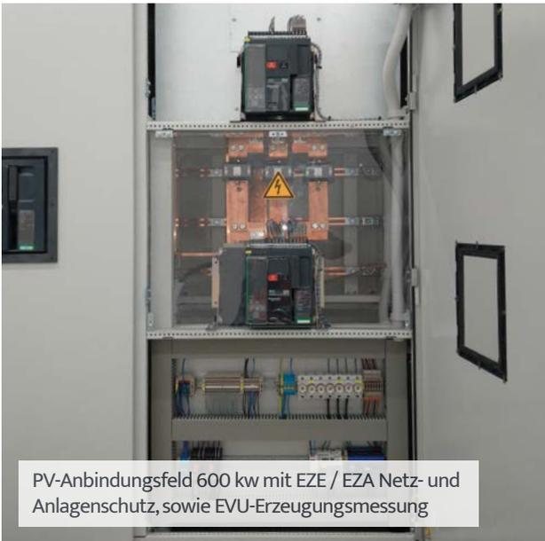
PV-Anbindungsfeld 600 kw mit EZE / EZA Netz- und Anlagenschutz, sowie EVU-Erzeugungsmessung
