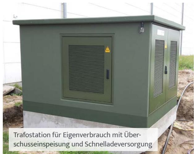
Trafostation für Eigenverbrauch mit Überschusseinspeisung und Schnelladeversorgung
