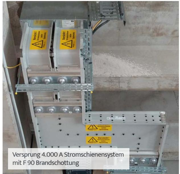
Versprung 4.000 A Stromschienensystem mit F 90 Brandschottung
