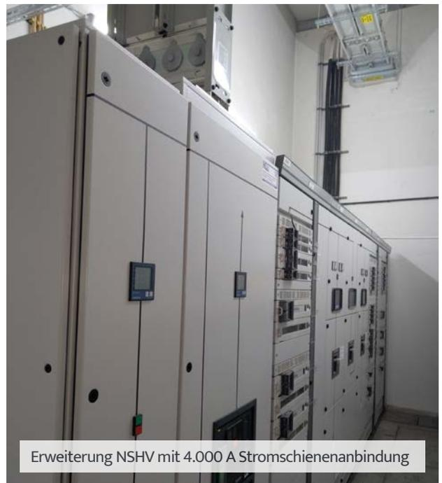
Erweiterung NSHV mit 4.000 A Stromschienenanbindung
