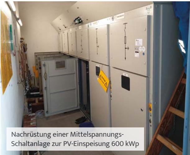
Nachrüstung einer Mittelspannungsschaltanlage zur PV-Einspeisung 600 kWp
