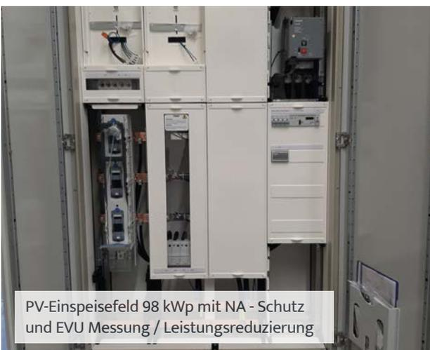
PV-Einspeisefeld 98 kWp mit NA - Schutz und EVU Messung / Leistungsreduzierung
