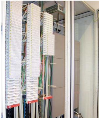
Hicom-Anlage mit herkömmlicher LSA-Plus Anschlußtechnik
