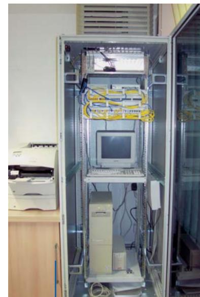
Voll integrierte Lösung mit Patchfeldern, Applikationsserver, Telefonanlage mit ISDN-NTBA, USV-Anlage und Aufsatzkühlgerät.
